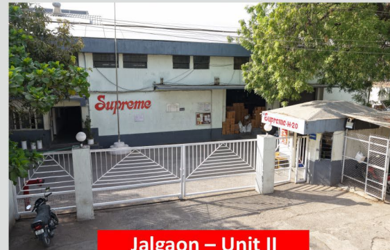
Jalgaon – Unit II
