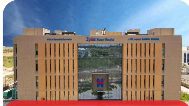
Zydus Hospital Sitapur (Epc Project)
