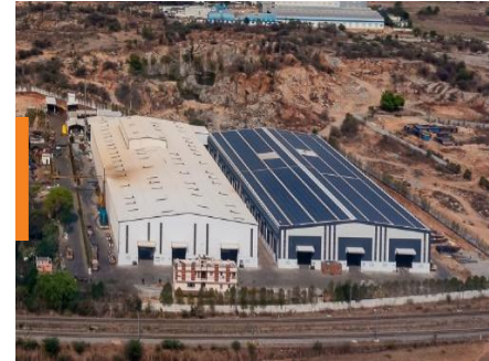
Mahabubnagar Unit-IV Telangana
