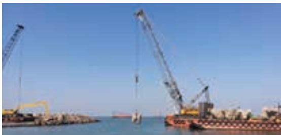
Breakwater under construction at Dabhol LNG Terminal
