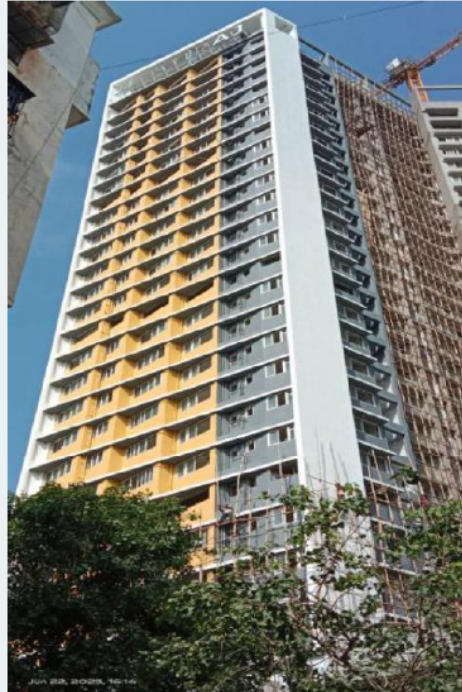
Tenant Building Ave Maria
