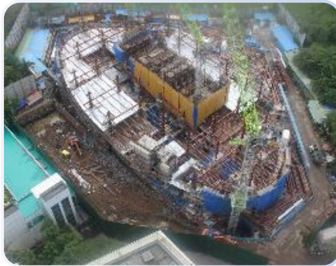
Actual Site Image
