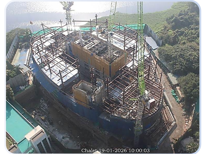
Actual Site Image
