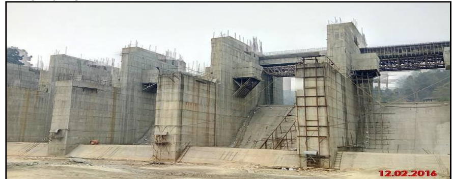
New Umtru H E Project
