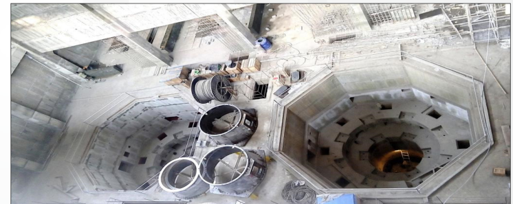
New Umtru H E Project
