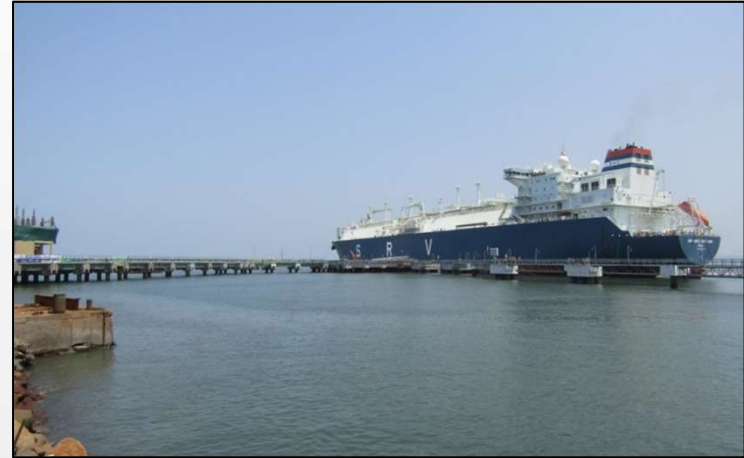
LNG Terminal for H-Energy, Raigad
