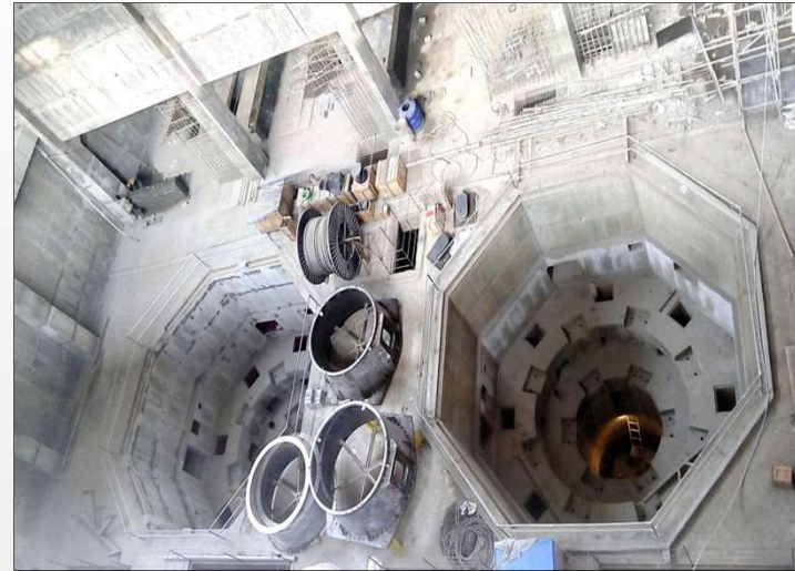
New Umtru H E Project
