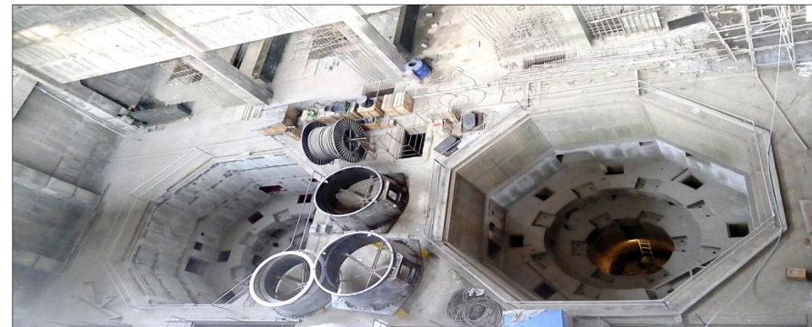
New Umtru H E Project
