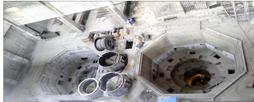
New Umtru H E Project
