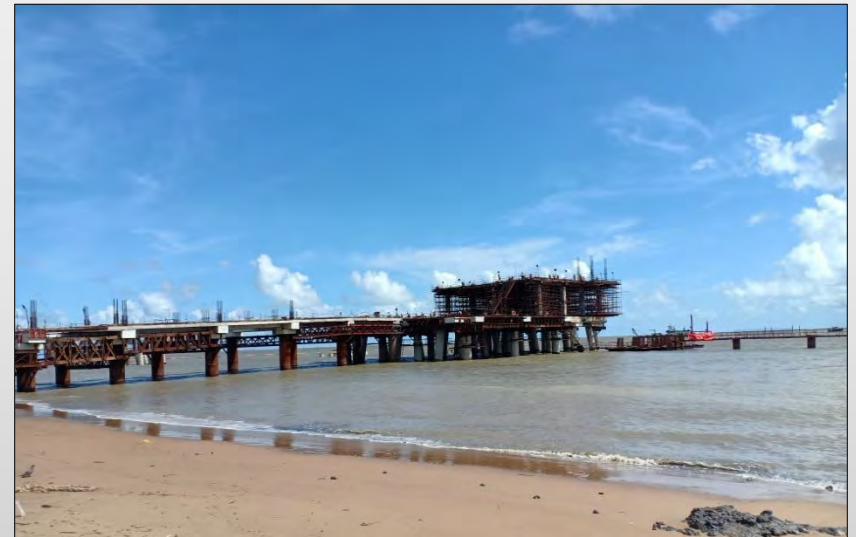
Dhamra, LNG Jetty, Orissa
