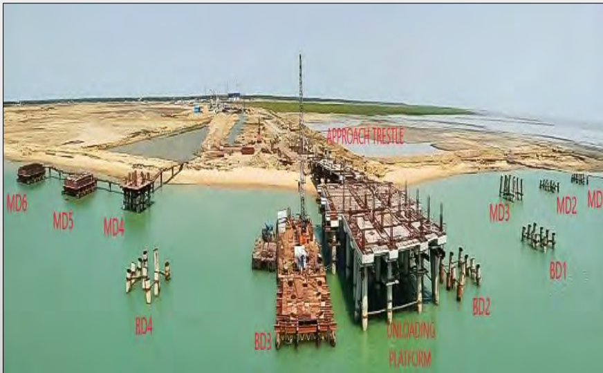
Dhamra , LNG Jetty, Orissa
