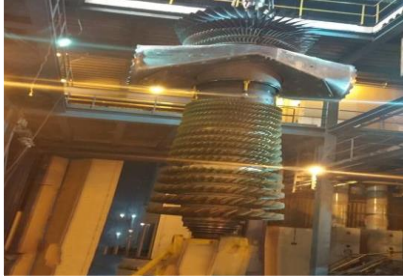
SIEMENS -138MW GAS TURBINE PAGUTHAN
