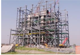
1X660 MW TPP, BTG, HARDUAGANJ, DOOSAN
