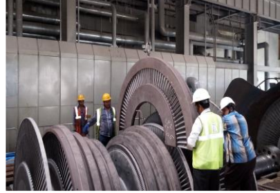
TG OVERHAUING 600MW JHARSUGUDA VEDANTA
