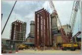
250 MW SABIYA CCPP, KUWAIT INSTALLATION OF HRSG
