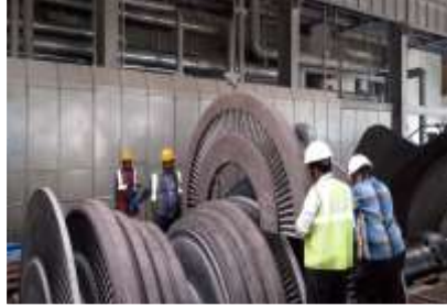
TG OVERHAUING 600MW JHARSUGUDA VEDANTA
