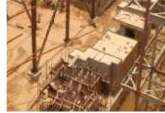
3X660 MW, STPP, STG,BOP ,NORTH KARNAPURA, BHEL
