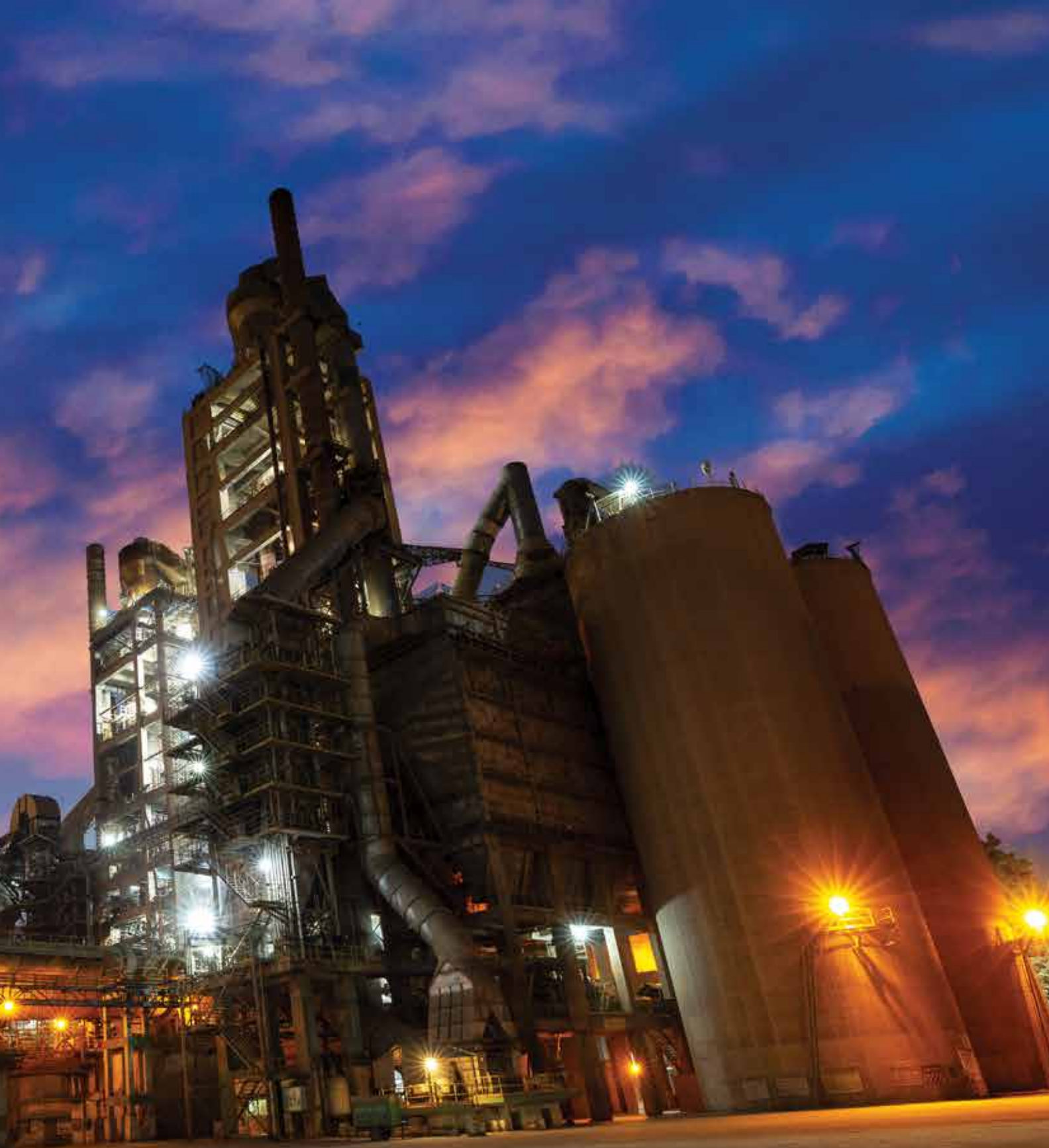
CLINKERISATION UNIT, NARSINGARH (DAMOH)
