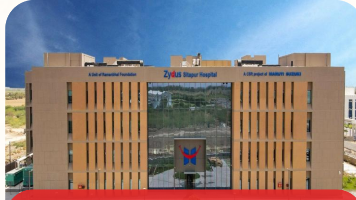
Zydus Hospital Sitapur (Epc Project)
