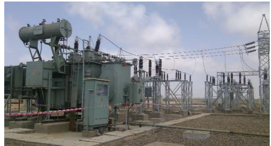
Actual site photographs
