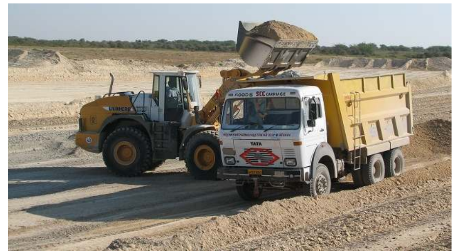
Actual site photographs
