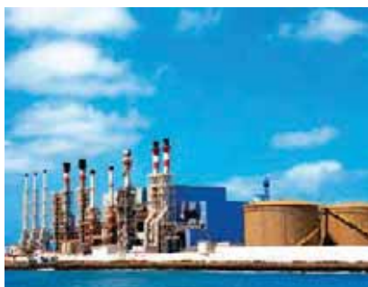
Thermal desalination plant.
