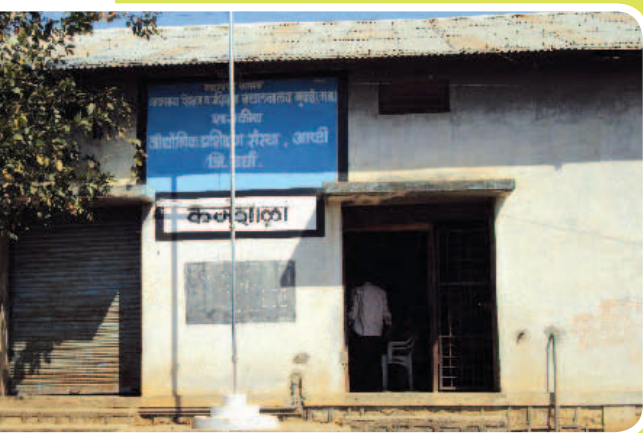
Existing ITI Premises
