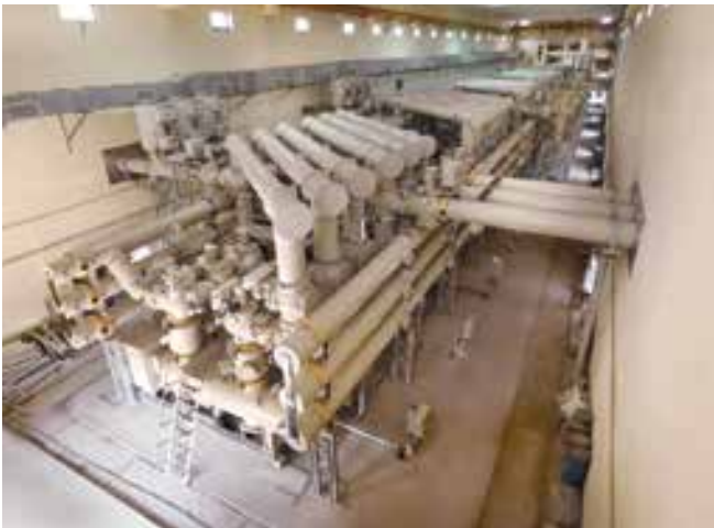
► 400 kV GIS Substation
