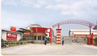
AGL Dalpur Plant (Wall Tiles)
