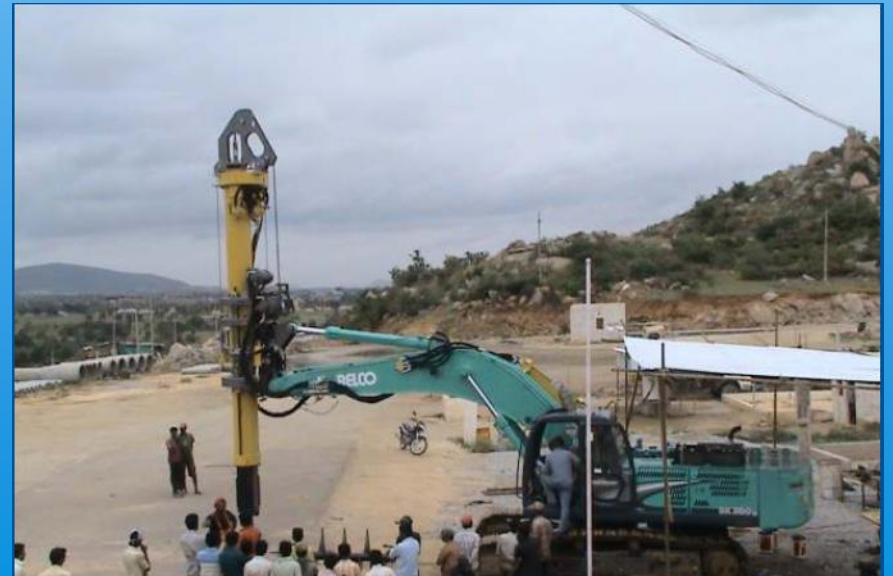
Low Drill – DH – 60 Piling Machine
