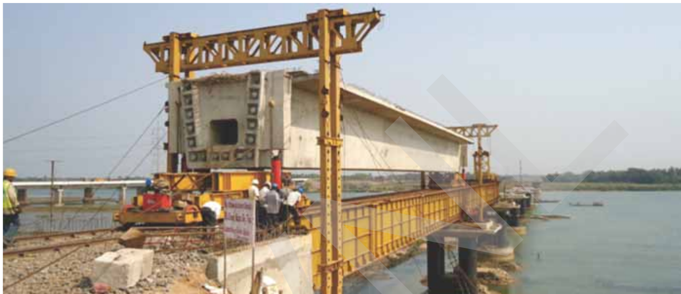
पीएससी गर्डर लूना पुल पर PSC Girder on Luna Bridge
