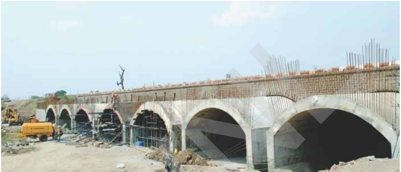
दोहरीकरण लाईन के लिए आरसीसी आर्क टॉप बॉक्स RCC Arch Top Box for the doubling line
