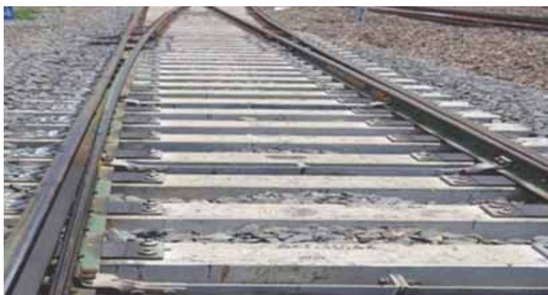
प्वाइंट और क्रॉसिंग पर जस्ती ट्रैक फिटिंग Galvanised Track Fittings on Points and Crossings
